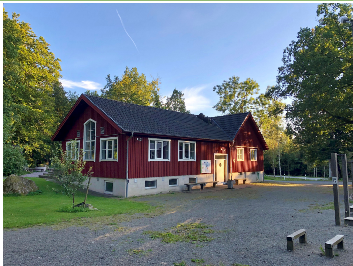
FK Göingarnas friluftsanläggning i Tågaröd
