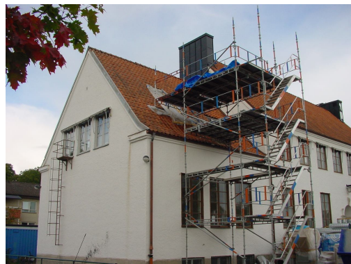
Ny ventilation på väg in i Kulturhuset Vita skolan via taket. Bild tagen 2008-10-02.
