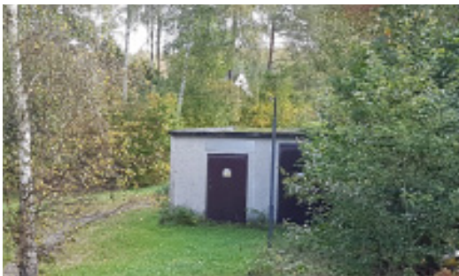
Teknisk anläggning vid Grottevägen
