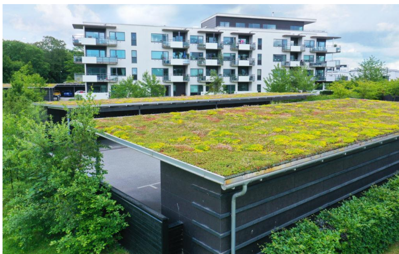
Figur 12: Vegetationklätt sedumtak (Bild: VegTech, 2022-09-16)
