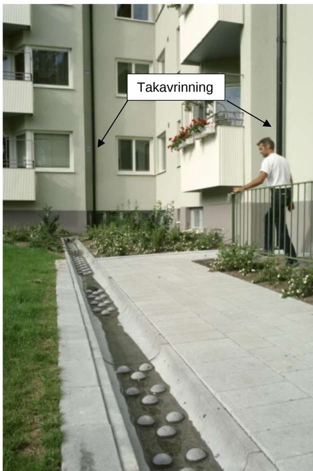
Figur 15: Exempelbild på avvattningsränna i anslutning till tak.
