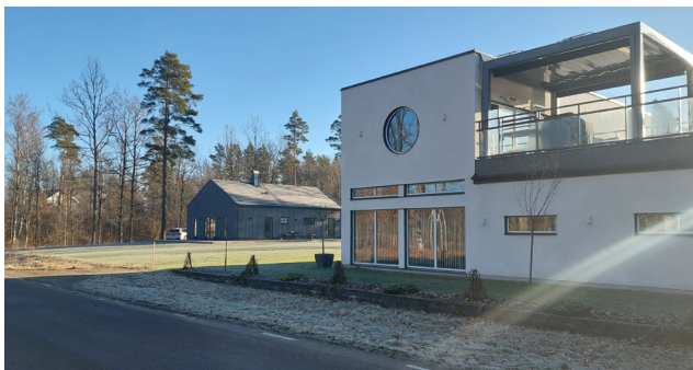
Njuravägen Vy mot nordöst. Byggnader utmed Njuravägen som kontrasterar varandra.
